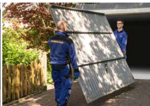
Ausbau und umweltgerechte Entsorgung
